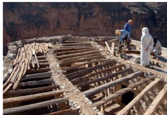
LA RESTAURATION DES CHARPENTES SE FAIT TRÈS RÉGULIÈREMENT EN FONCTION DE L'USURE DES BOIS OU DES STIPE DE PALMIER, GRENIER D'AGUELOU, 2004, R.S.N.
